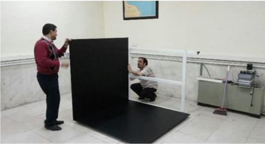
شکل (۴): نصب صفحات فضای استاندارد با انجام پوشش و تنظیمات لازم جهت استقرار صفحات بر روی اسکلت زیرساخت.
