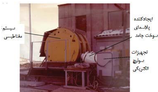
شکل (۶): پالس ژنراتور استفاده‌شده در تیان شان [۷].
