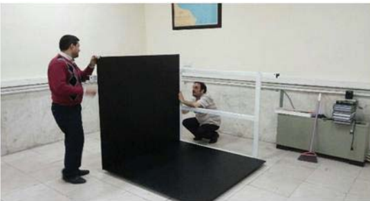
شکل (۴): نصب صفحات فضای استاندارد با انجام پوشش و تنظیمات لازم جهت استقرار صفحات بر روی اسکلت زیرساخت.
